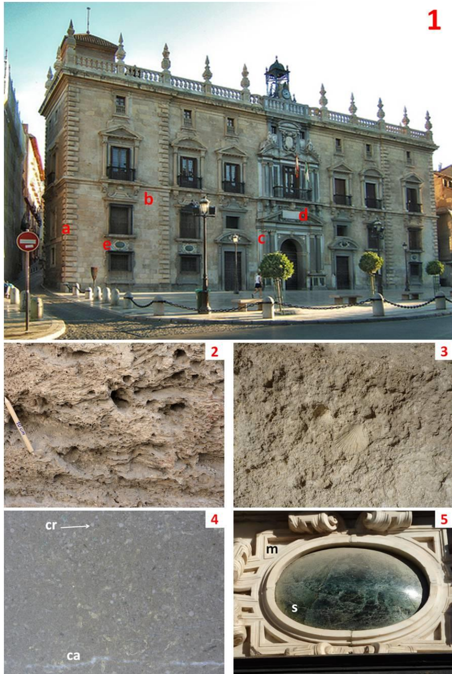
Figura 6. 1) Fachada de la Real Chancillería en la que se observa: el travertino ocre-dorado de Alfacar (a) en muros laterales y sillares almohadillados de la fachada principal; la calcarenita ocre-amarillenta de Santa Pudia (b) en el paramento central y ornatos de ventanas, cornisas y crestería; la caliza gris de Sierra Elvira (c) en columnas y frontones de las portadas de la fachada; el mármol blanco de Macael (d) en el escudo y cartela de la portada principal y enmarcando los medallones de serpentinita verde (e) del Barranco de San Juan (Sierra Nevada), también usada en los pedestales de las columnas de la portada principal. 2) Detalle del travertino de Alfacar con los huecos dejados por restos vegetales y la formación de coqueras. 3) Detalle de la calcarenita de Santa Pudia donde se observa la huella de una concha. 4) Detalle de la caliza gris de Sierra Elvira en que se ven los crinoides (cr) y una banda blanca de calcita (ca). 5) Detalle de un medallón de serpentinita verde (s) enmarcado por mármol blanco de Macael (m).
